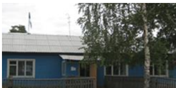
Здание администрации с/п «Яснэг», 2013 г.
