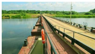
Новый понтонный мост Источник: http://qps.ru/GCwkn
