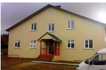
Новый двухэтажный дом в Яснэге для переселенцев
