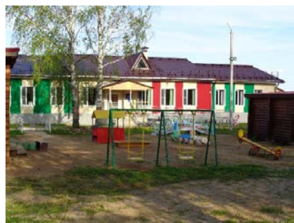
Новое здание детского сада. Источник: https://clck.ru/3MSUB5
