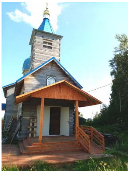
Строящийся храм Пресвятой Богородицы. Источник: https://clck.ru/3N2UjT
